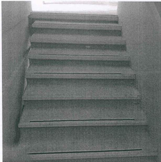
Instalación de antiderrapante en zona de alta densidad de movimiento
