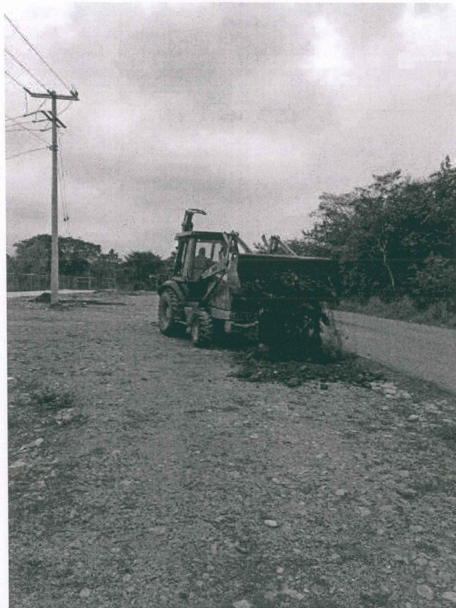
Relleno y terraceo de limite con la carretera federal
