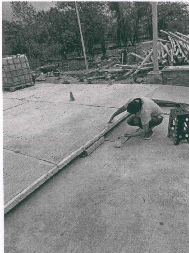
Pintura de áreas en desnivel que forman parte del acceso a la institución
