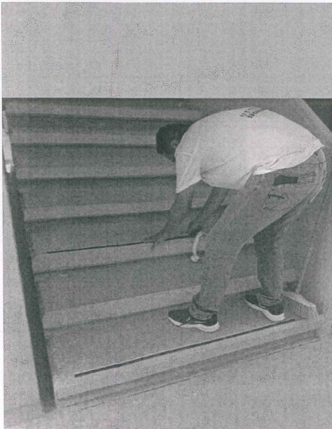
Instalación de antiderrapante en zona de alta densidad de movimiento
